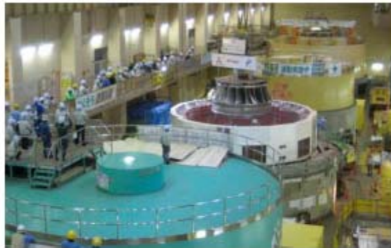
●水車発電機の一括更新工事による発電出力、電力量を向上(糠平発電所1・2号機が竣工、田子倉発電所1号機で実施中(現在までに2～4号機は終了))
