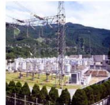
●東西の電力融通を可能とする佐久間周波数変換所。1965年10月運転開始
