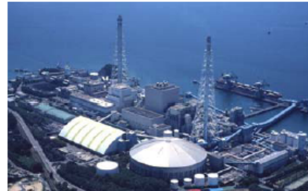
竹原火力発電所
