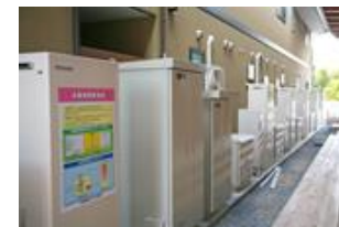
北九州水素タウンに設置の純水素機
