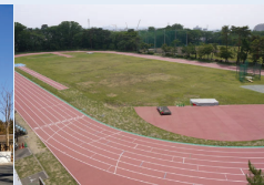
▲全天候型陸上競技場の改修
