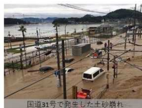
国道31号で発生した土砂崩れ
