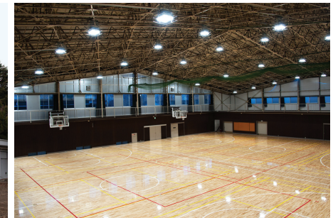
【館内】床を張り替え、照明をLEDに交換
