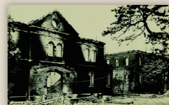
被災後の神田一ツ橋
