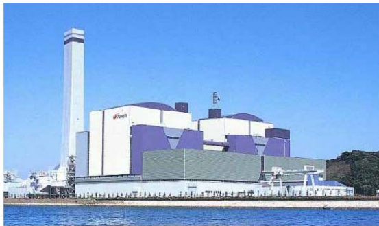
Jパワー橋湾火力発電所(徳島県)
