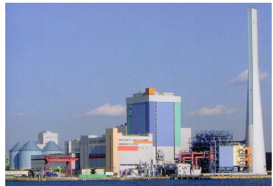
電源開発(株)磯子火力発電所(石炭火力 新1号機 60万kW) (2002年4月 営業運転開始)
