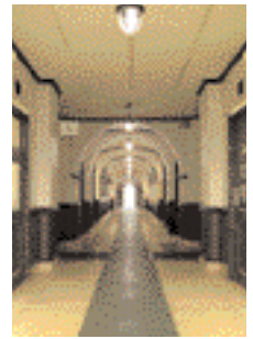
改修前の廊下
