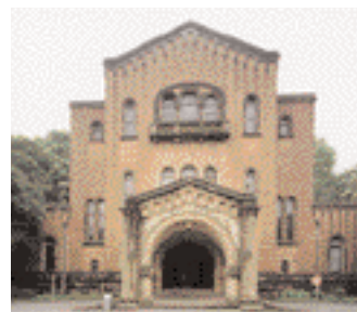
改修前の正面外観
