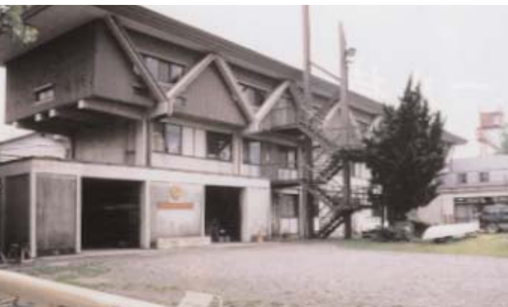
改修前の戸田艇庫
