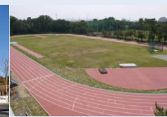
▲全天候型陸上競技場の改修
